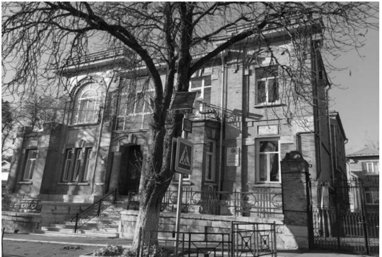
Фото 4. Объект культурного наследия регионального значения «Здание, в котором находилась детская коммуна, которую в 1925 году посетила Н.К. Крупская», Ставропольский край, г. Пятигорск, ул. Буачидзе, 7 (фактический адресу: ул. Буачидзе, 5). Главный фасад, вид с юго-востока.
