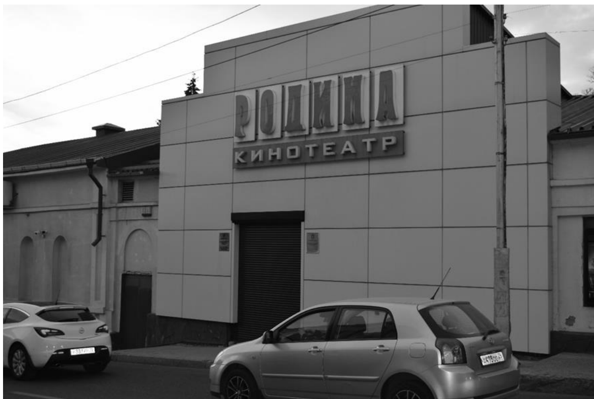
Фото 6. Объект культурного наследия регионального значения «Первый театр, который в 1853 г. посетил Л.Н. Толстой», 1846-1853 гг., Ставропольский край, г. Пятигорск, ул. Бернардацци, 4. Центральный ризалит главного фасада.
