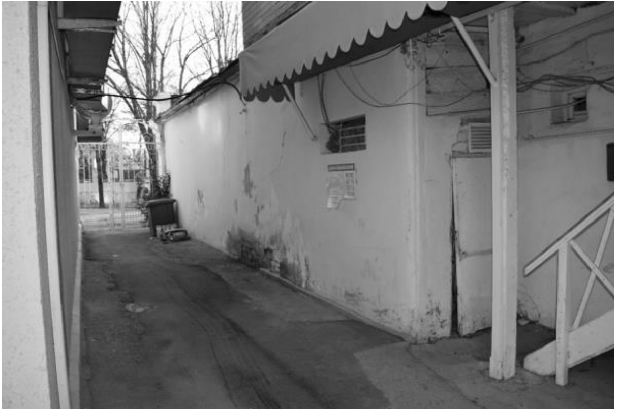
Фото 8. Объект культурного наследия регионального значения «Жилой дом с магазином», конец XIX в., расположенного по адресу: Ставропольский край, г. Пятигорск, пр. Кирова, 38. Восточный фасад (литер А).
