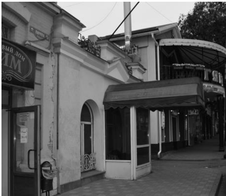
Фото 3. Объект культурного наследия регионального значения «Жилой дом с магазином», конец XIX в., расположенного по адресу: Ставропольский край, г. Пятигорск, пр. Кирова, 38. Главный фасад, вид с запада.
