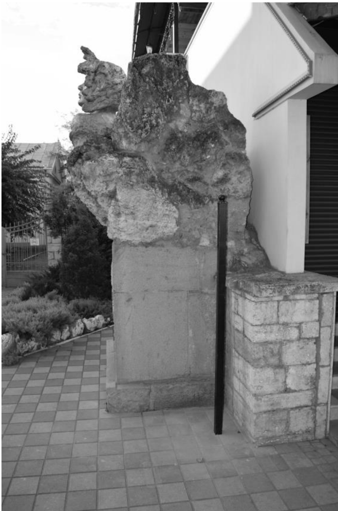
Фото 4. Объект культурного наследия регионального значения «Памятник партизанке Н. Попцовой», 1961 г., Ставропольский край, г. Пятигорск, пр. Кирова, 41. Вид торцевой части памятника.
