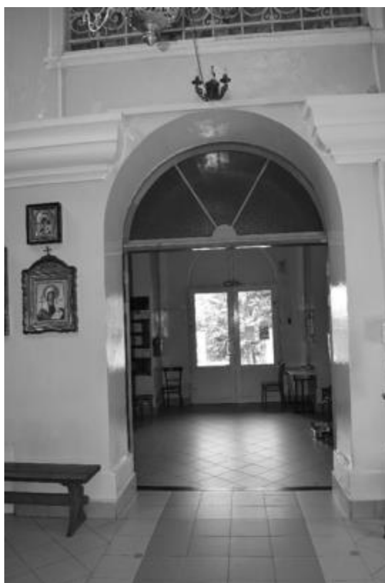
Фото 12. Объект культурного наследия регионального значения «Лазаревская церковь», 1903 г., Ставропольский край, г. Пятигорск, ул. Пастухова, 1. Арочный дверной проем.
