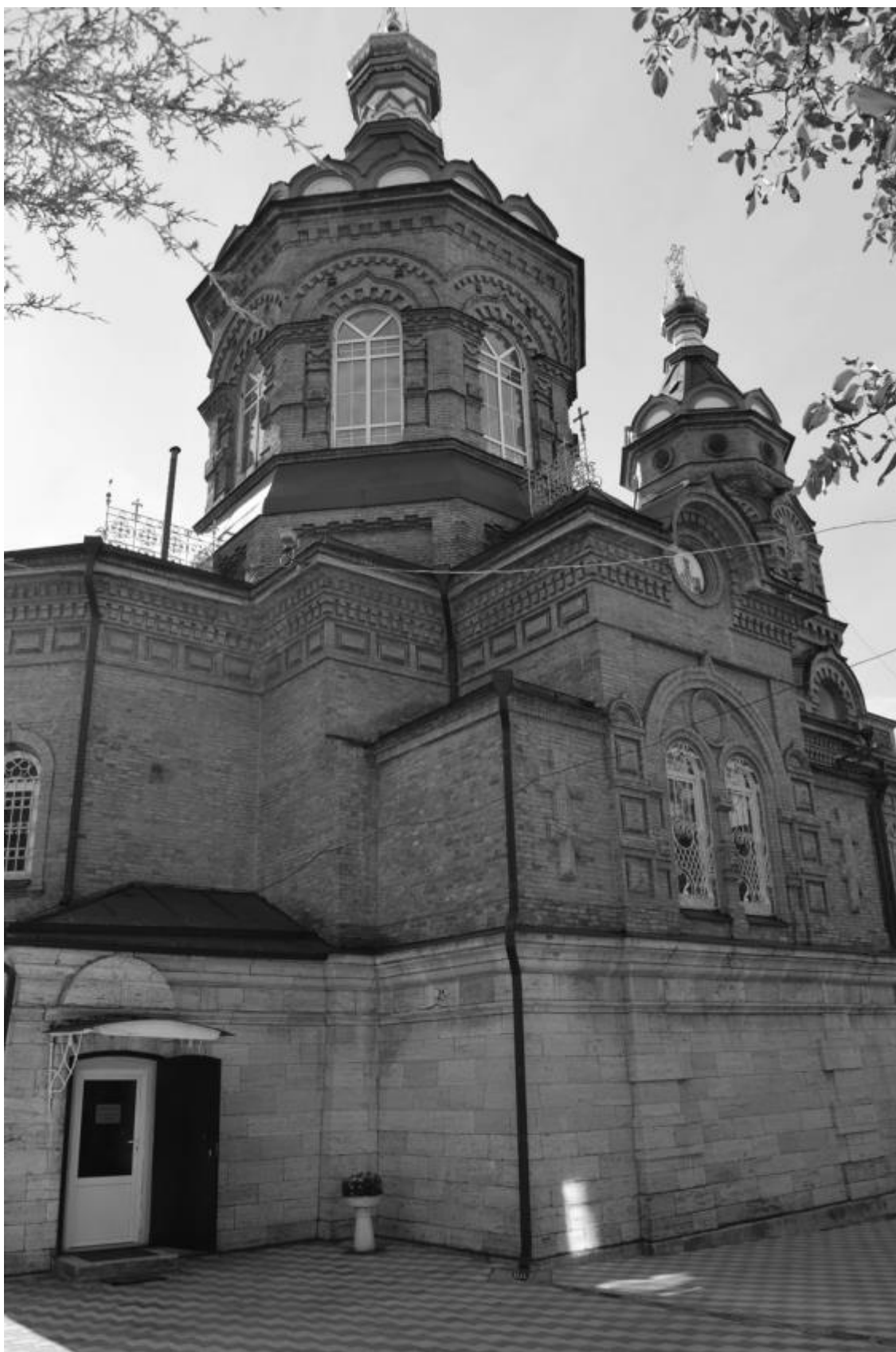
Фото 4. Объект культурного наследия регионального значения «Лазаревская церковь», 1903 г., Ставропольский край, г. Пятигорск, ул. Пастухова, 1. Фрагмент северного фасада.
