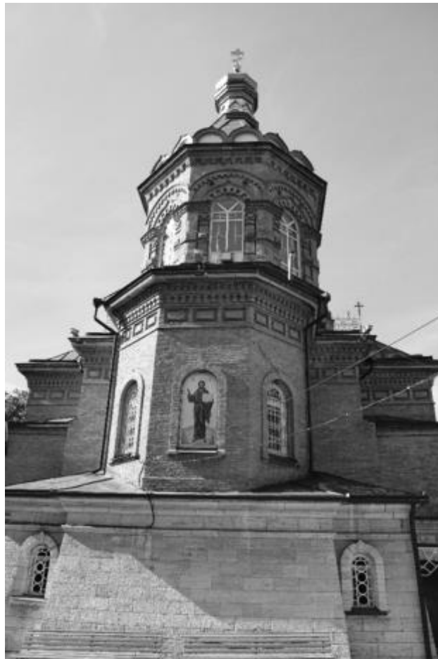
Фото 6. Объект культурного наследия регионального значения «Лазаревская церковь», 1903 г., Ставропольский край, г. Пятигорск, ул. Пастухова, 1. Восточный фасад.
