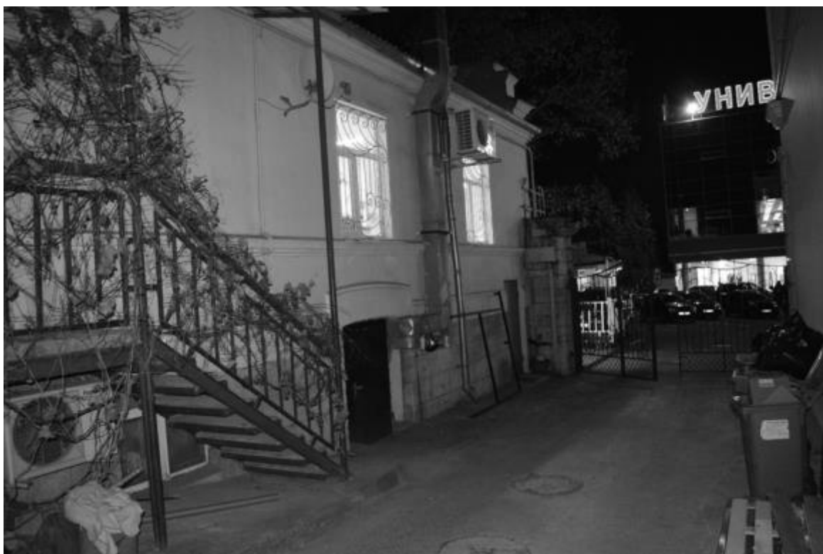
Фото 7. Объект культурного наследия регионального значения «Особняк», кон. XIX в., Ставропольский край, г. Пятигорск, ул. Мира, 14. Западный фасад.
