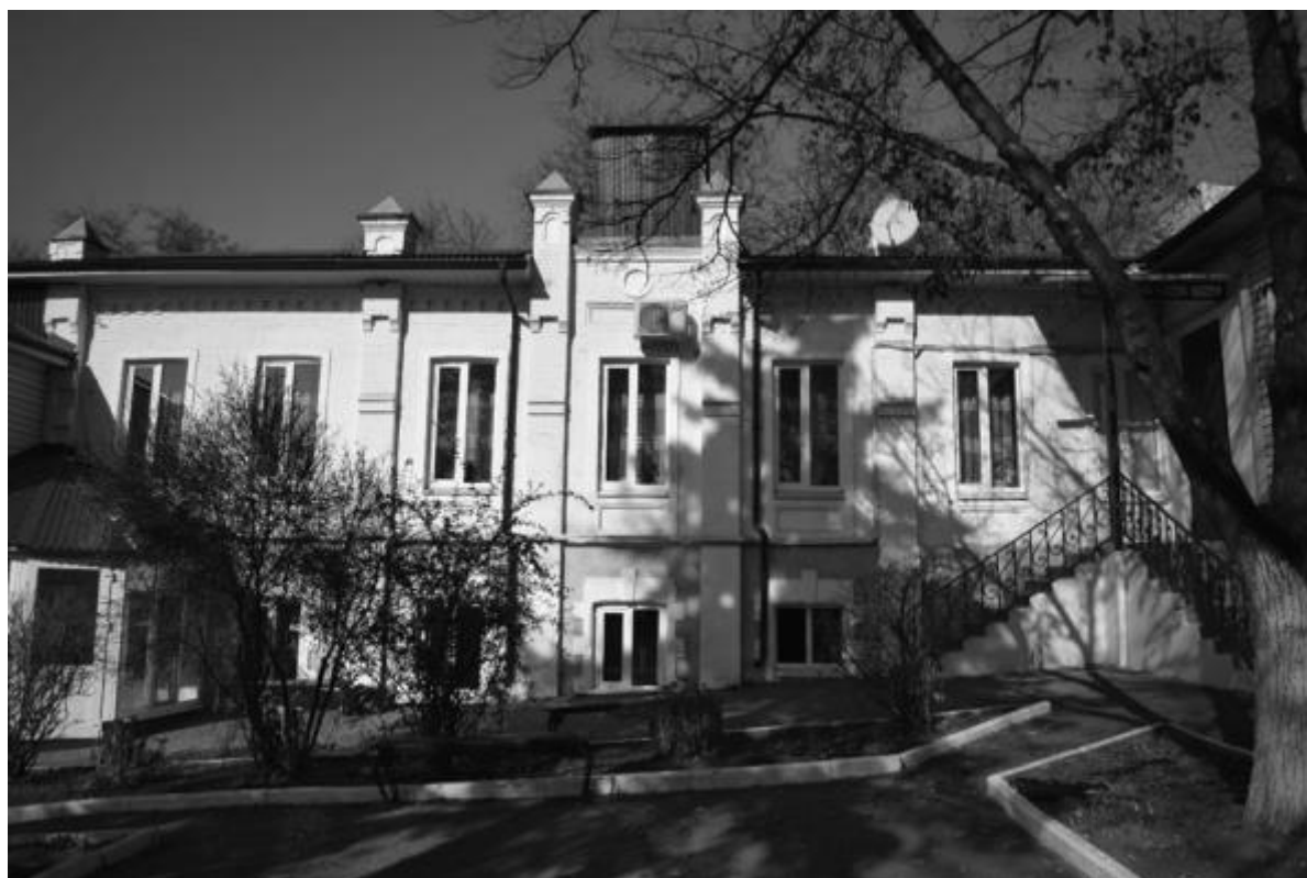
Фото 3. Объект культурного наследия регионального значения «Подсобные строения (два)», 1864 г., в составе объекта культурного наследия регионального значения «Ансамбль лютеранской кирхи», 1894 г., Ставропольский край, г. Пятигорск, ул. Лермонтова, 3. Южный фасада литера Б.
