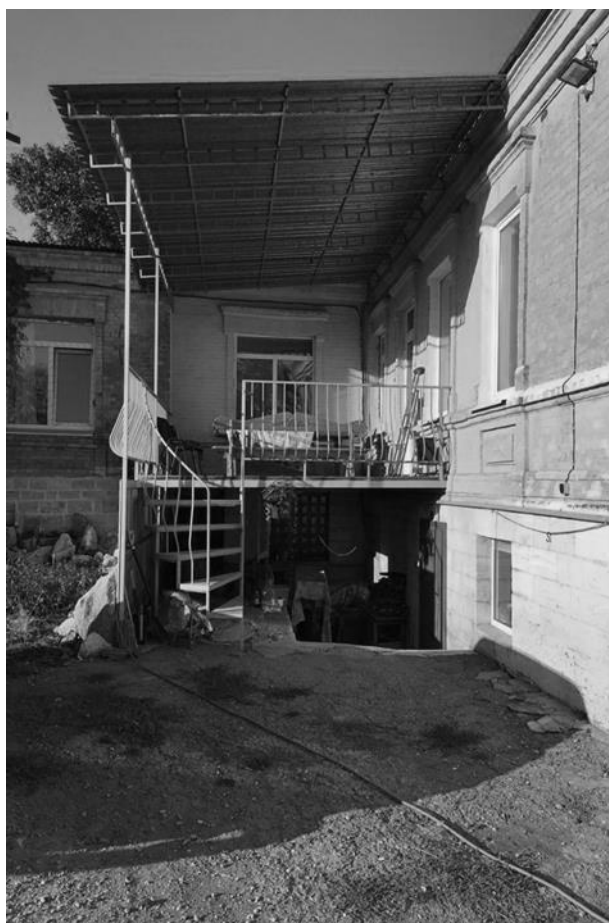
Фото 4-5. Объект культурного наследия регионального значения «Особняк «Дом губернатора», кон. XIX в., Ставропольский край, г. Пятигорск, ул. Соборная, 9. Фрагмент западного фасада литера А, южный фасад литера А1.
