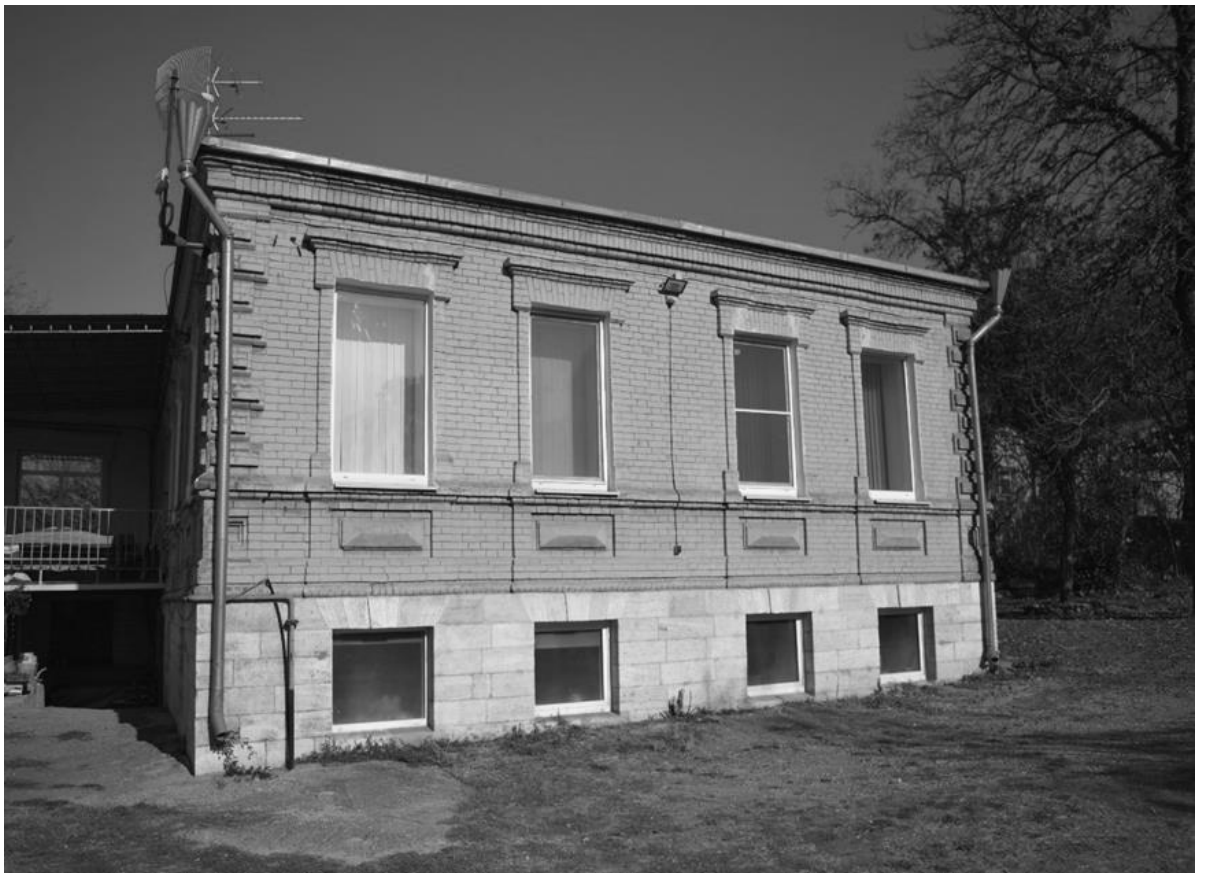
Фото 2-3. Объект культурного наследия регионального значения «Особняк «Дом губернатора», кон. XIX в., Ставропольский край, г. Пятигорск, ул. Соборная, 9. Южный фасад памятника.
