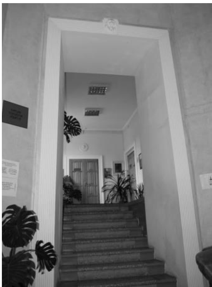
Фото 10. Объект культурного наследия регионального значения «Особняк», 1915 г., Ставропольский край, г. Пятигорск, пр. Кирова, 33. Лестница, ведущая в литер А1. Оформление дверного проема.
