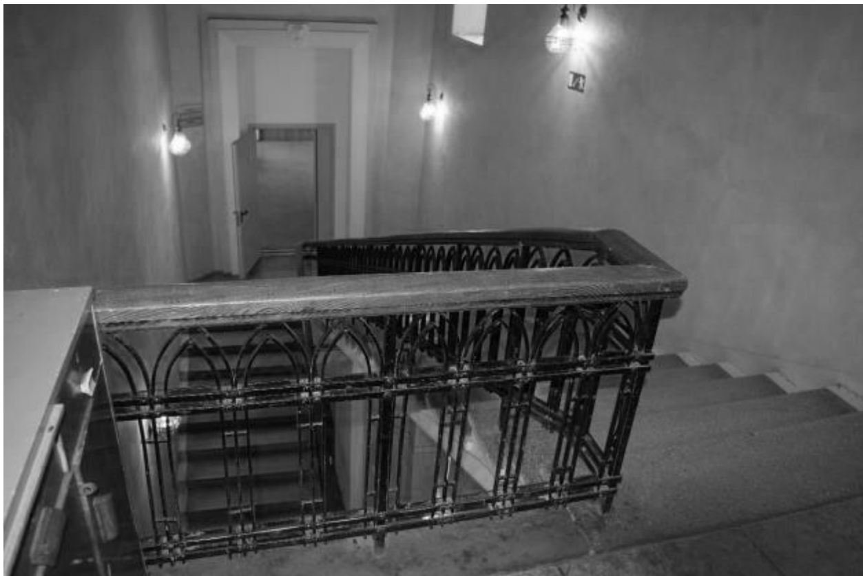
Фото 9. Объект культурного наследия регионального значения «Особняк», 1915 г., Ставропольский край, г. Пятигорск, пр. Кирова, 33. Фрагмент лестничного ограждения.
