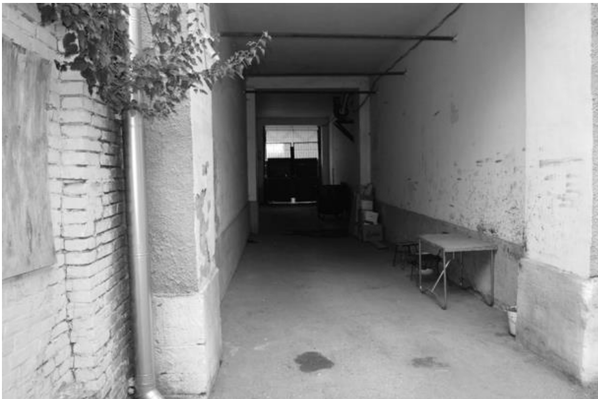
Фото 6. Объект культурного наследия регионального значения «Особняк», 1915 г., Ставропольский край, г. Пятигорск, пр. Кирова, 33. Проезд на дворовую территорию.
