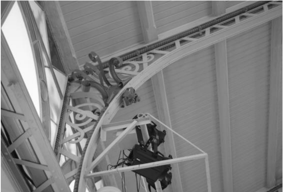
Фото 28-30. Объект культурного наследия регионального значения «Лермонтовская галерея», 1901 г., Ставропольский край, г. Пятигорск, пр. Кирова, 21-а. Декоративные детали.
