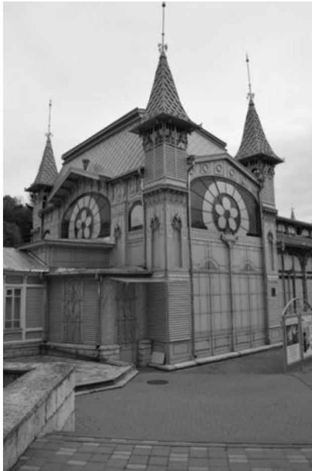
Фото 14. Объект культурного наследия регионального значения «Лермонтовская галерея», 1901 г., Ставропольский край, г. Пятигорск, пр. Кирова, 21-а. Западный объем.
