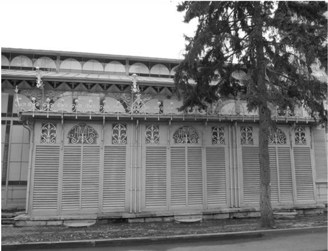
Фото 11-12. Объект культурного наследия регионального значения «Лермонтовская галерея», 1901 г., Ставропольский край, г. Пятигорск, пр. Кирова, 21-а. Техническое помещение на юго-восточном фасаде памятника.
