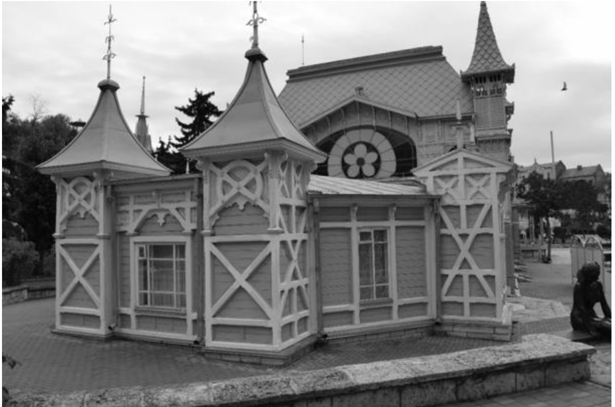
Фото 17-18. Объект культурного наследия регионального значения «Лермонтовская галерея», 1901 г., Ставропольский край, г. Пятигорск, пр. Кирова, 21-а. Фахверковый объем, общий вид.
