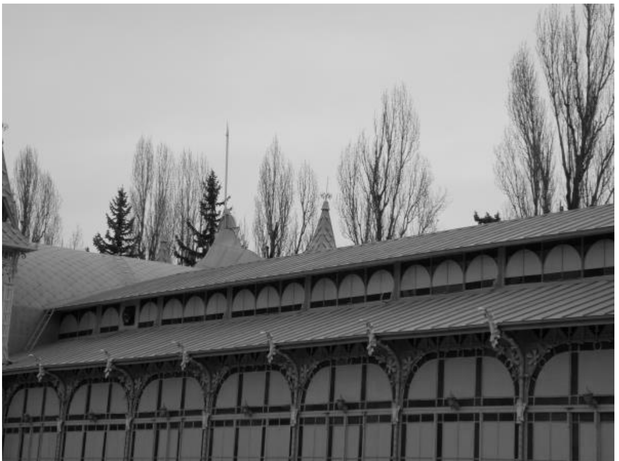
Фото 3. Объект культурного наследия регионального значения «Лермонтовская галерея», 1901 г., Ставропольский край, г. Пятигорск, пр. Кирова, 21-а. Общий вид памятника.
