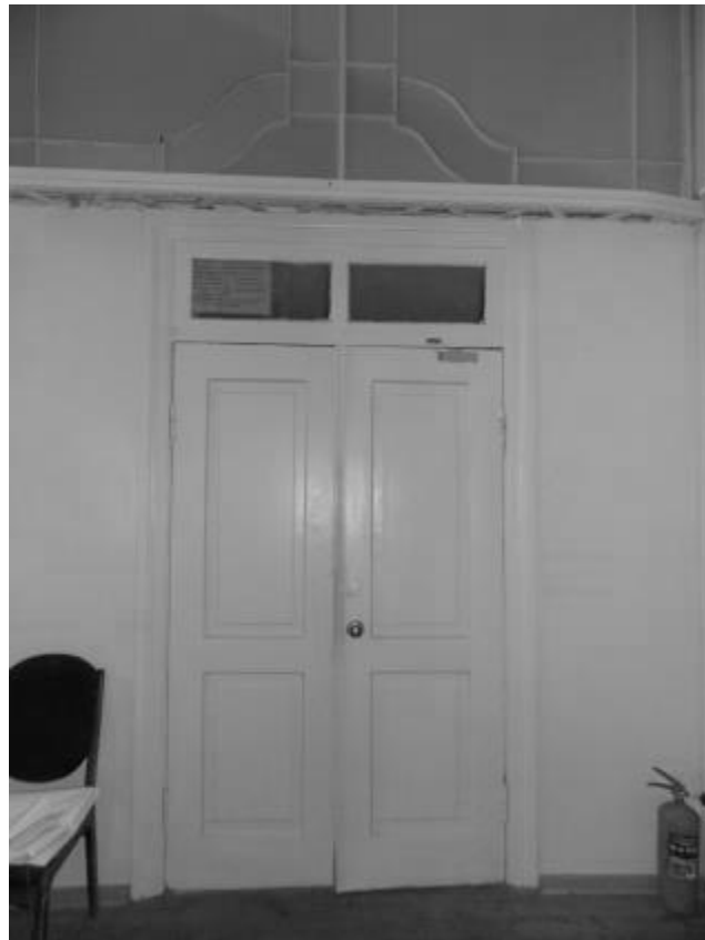
Фото 24. Объект культурного наследия регионального значения «Лермонтовская галерея», 1901 г., Ставропольский край, г. Пятигорск, пр. Кирова, 21-а. Внутренние двери.
