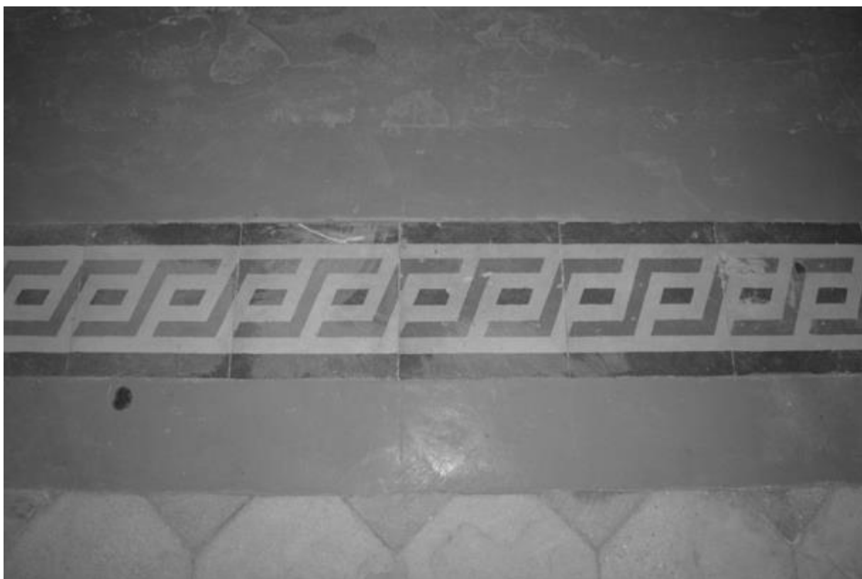
Фото 36. Объект культурного наследия регионального значения «Лермонтовская галерея», 1901 г., Ставропольский край, г. Пятигорск, пр. Кирова, 21-а. Фрагмент покрытия пола.
