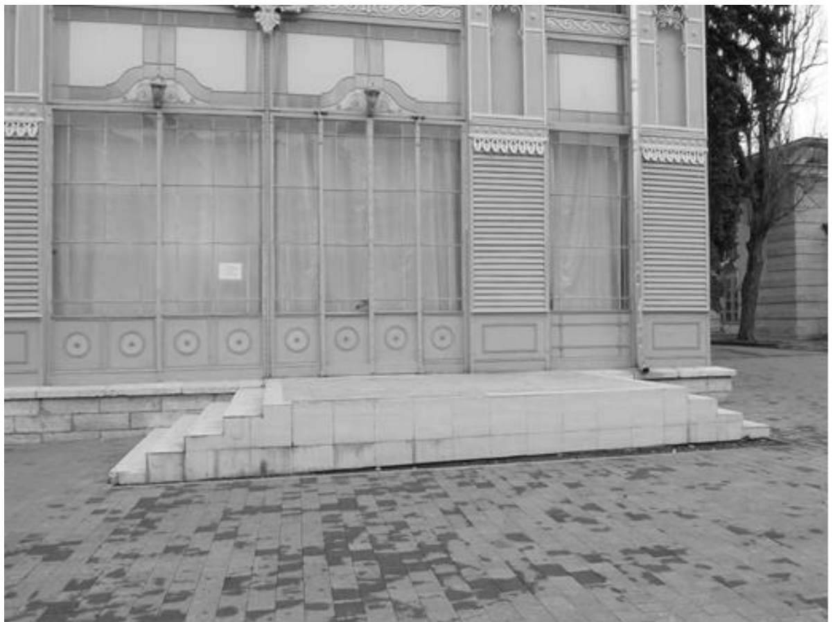
Фото 8-9. Объект культурного наследия регионального значения «Лермонтовская галерея», 1901 г., Ставропольский край, г. Пятигорск, пр. Кирова, 21-а. Юго-западный фасад памятника.
