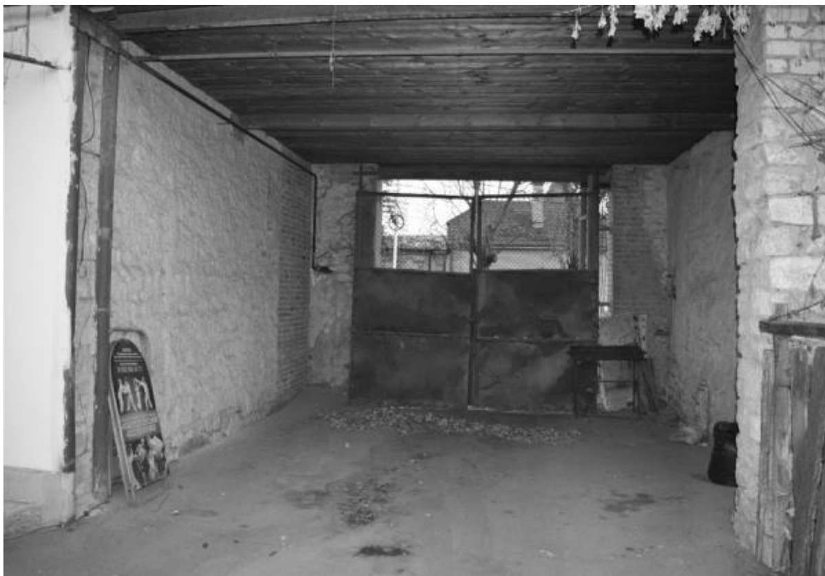
Фото 8. Объект культурного наследия регионального значения «Лечебница «Приют Святой Ольги», 1872 г., Ставропольский край, г. Пятигорск, ул. Дзержинского, 78. Проезд на дворовую территорию.
