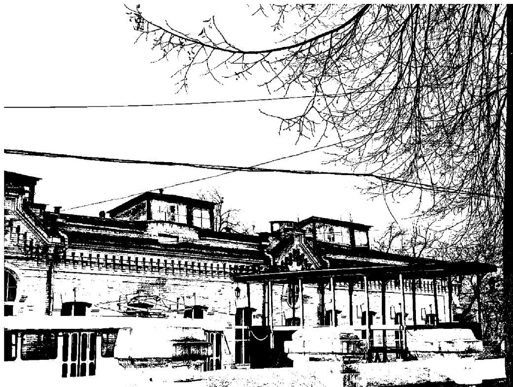
Фото 10-21. Объект культурного наследия регионального значения «Здание трамвайного парка, в котором выступали С.М. Киров и Г.К. Орджоникидзе», 1903 год, расположено по адресу: Ставропольский край, г. Пятигорск, просп. Дзержинского, 85. Общий вид литера «Г» с территории двора.
