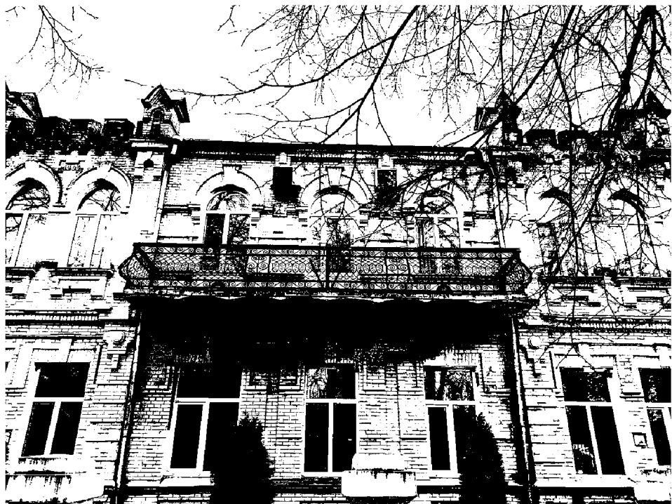
Фото 1-2. Объект культурного наследия регионального значения «Здание трамвайного парка, в котором выступали С.М. Киров и Г.К. Орджоникидзе», 1903 год, расположено по адресу: Ставропольский край, г. Пятигорск, просп. Дзержинского, 85.
