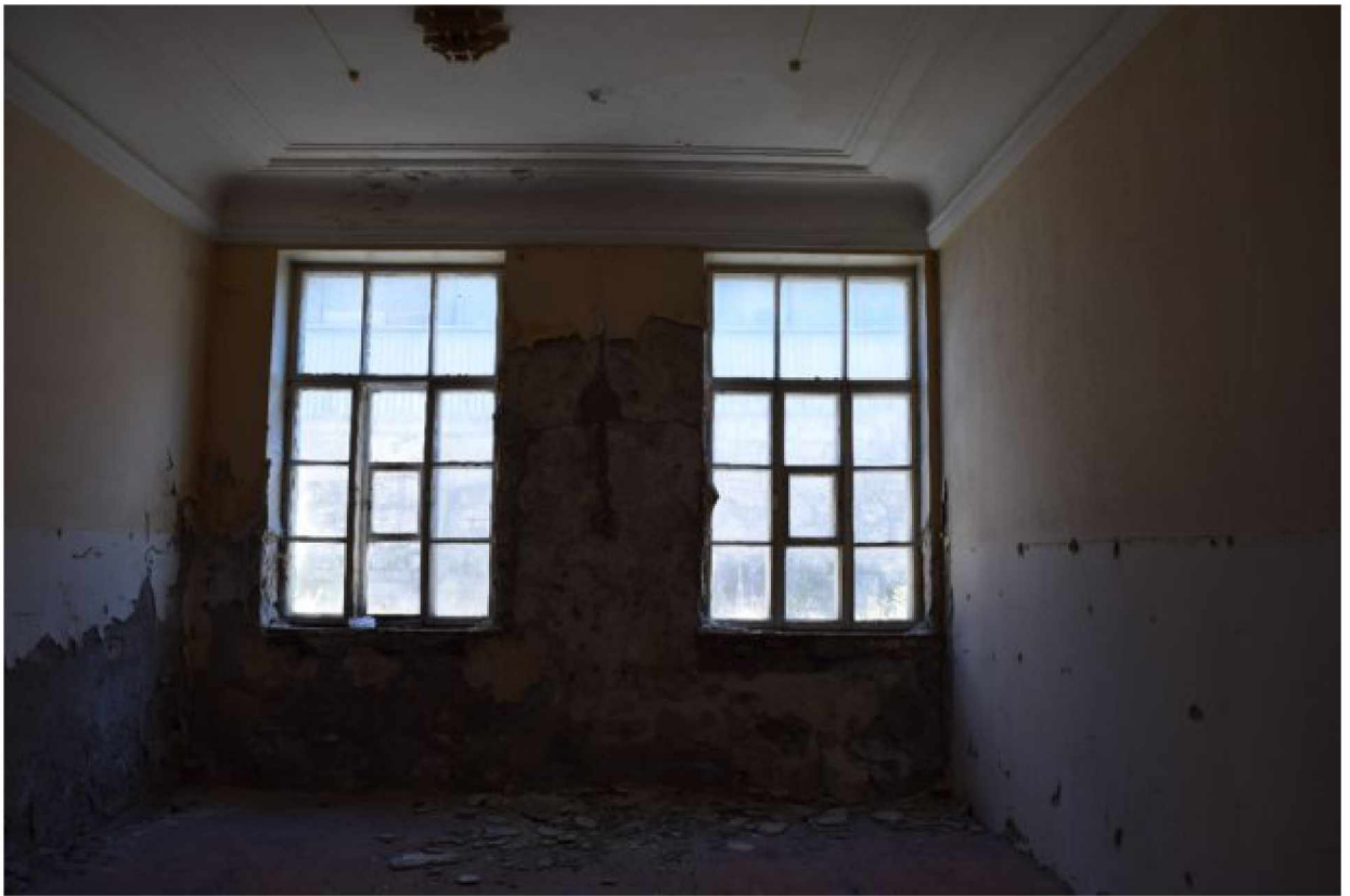
Фото 28. Объект культурного наследия федерального значения «Здание Лермонтовских ванн», 1831 год, расположен по адресу: Ставропольский край, г. Пятигорск, просп. Кирова, д. 21. Фрагмент интерьера: штукатурные тянутые карнизы.
