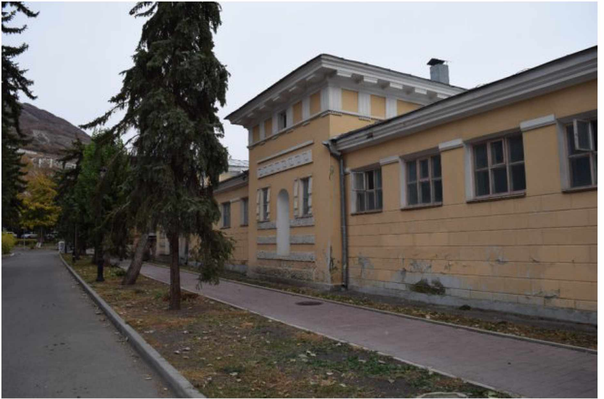
Фото 2. Объект культурного наследия федерального значения «Здание Лермонтовских ванн», 1831 год, расположен по адресу: Ставропольский край, г. Пятигорск, просп. Кирова, 21. Фрагмент главного фасада.
