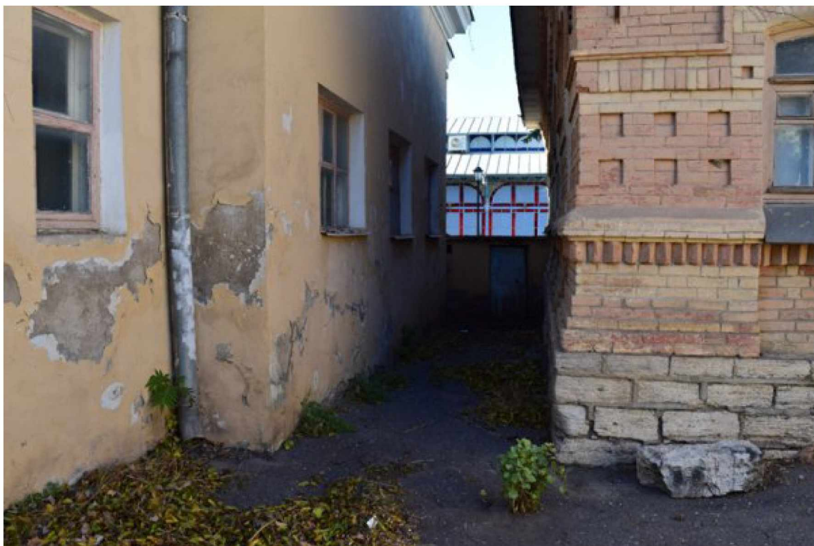
Фото 6-7. Объект культурного наследия федерального значения «Здание Лермонтовских ванн», 1831 год, расположен по адресу: Ставропольский край, г. Пятигорск, просп. Кирова, д. 21. Фрагменты северной части памятника.
