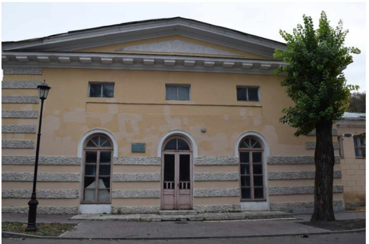
Фото 3. Объект культурного наследия федерального значения «Здание Лермонтовских ванн», 1831 год, расположен по адресу: Ставропольский край, г. Пятигорск, просп. Кирова, д. 21. Центральный объем.
