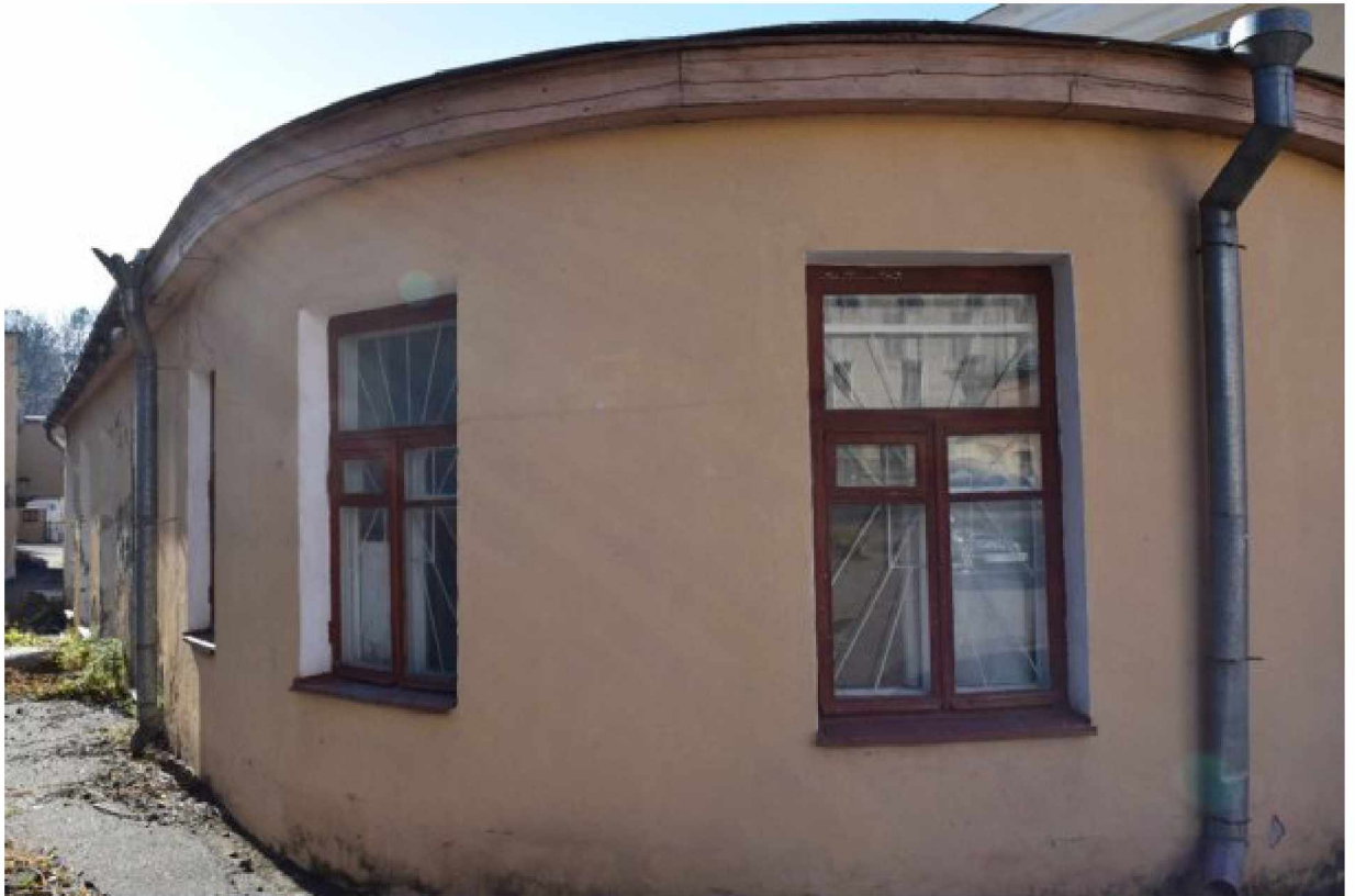
Фото 14-15. Объект культурного наследия регионального значения «Здание Лермонтовских ванн», 1831 год, расположен по адресу: Ставропольский край, г. Пятигорск, просп. Кирова, д. 21. Фрагмент дворового фасада.
