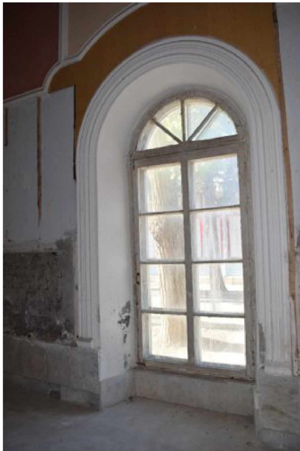
Фото 23. Объект культурного наследия федерального значения «Здание Лермонтовских ванн», 1831 год, расположен по адресу: Ставропольский край, г. Пятигорск, просп. Кирова, д. 21. Оконное заполнение.
