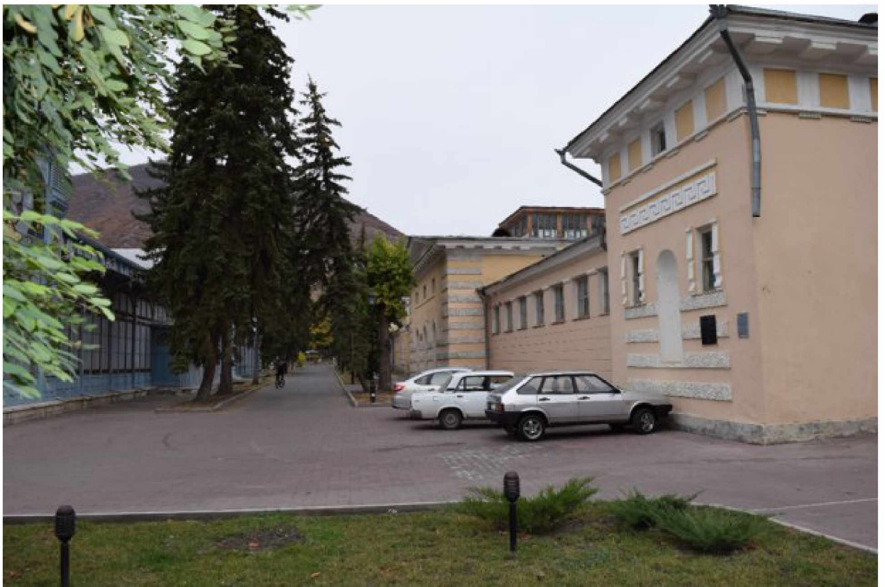
Фото 1. Объект культурного наследия регионального значения «Здание Лермонтовских ванн (бывш. Николаевские)», 1831 год, расположен по адресу: Ставропольский край, г. Пятигорск, просп. Кирова, д. 23.
