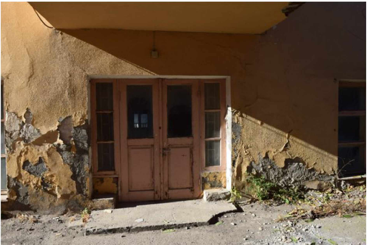
Фото 14-15. Объект культурного наследия регионального значения «Здание Лермонтовских ванн (бывш. Николаевские)», 1831 год, расположен по адресу: Ставропольский край, г. Пятигорск, просп. Кирова, д. 23. Фрагмент дворового фасада.
