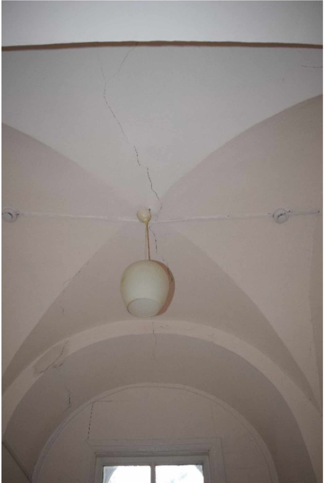
Фото 10-12. Объект культурного наследия регионального значения «Ансамбль лютеранской кирхи», 1894 год, расположен по адресу: Ставропольский край, г. Пятигорск, ул. Лермонтова, д. 3. Фрагменты интерьера кирхи.
