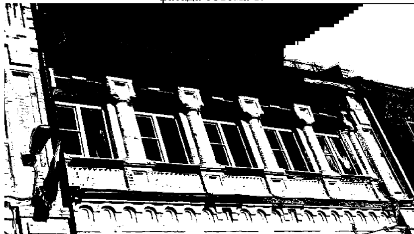
Декор второго этажа боковых частей юго-западного фасада объема I:
