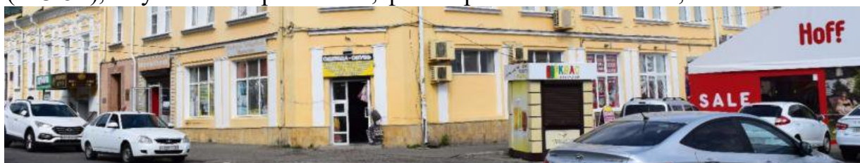
Оконные проемы первого этажа главных фасадов.
