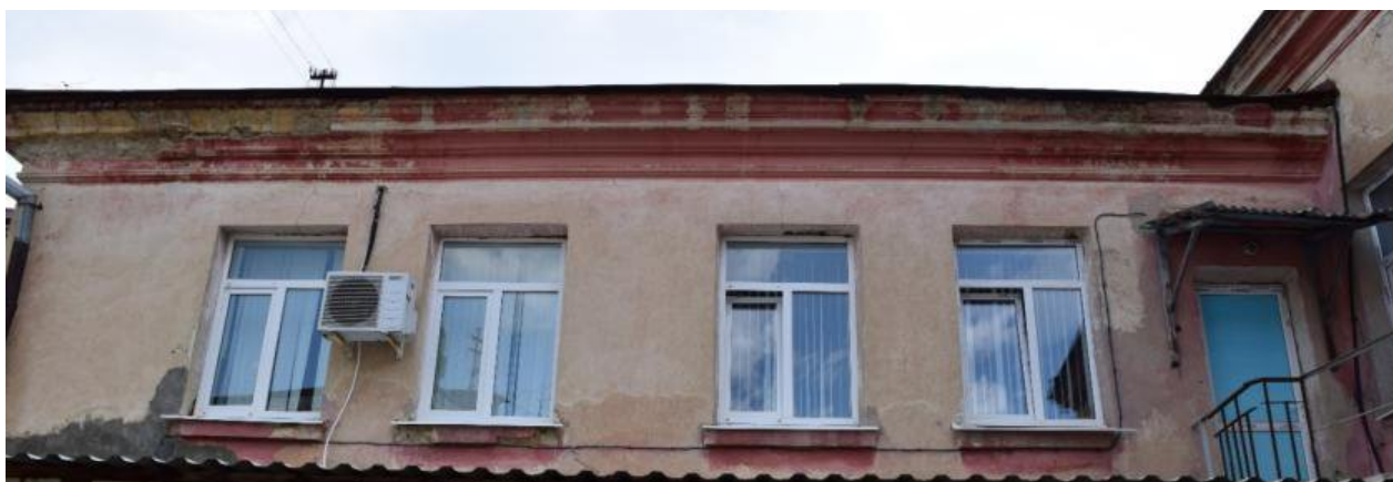
Оконные проемы второго этажа западного (дворового) фасада
