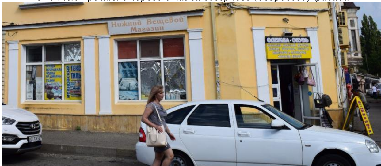
Пилястры главного южного и юго-восточного фасада
