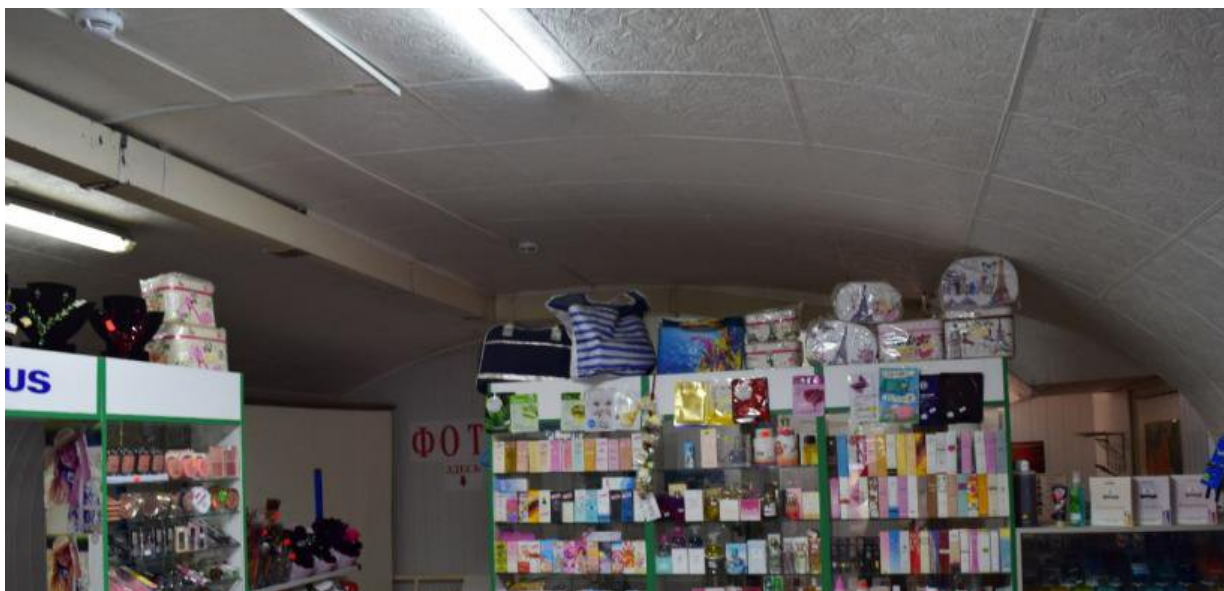
Сводчатый потолок цокольного этажа (коробовый свод)
