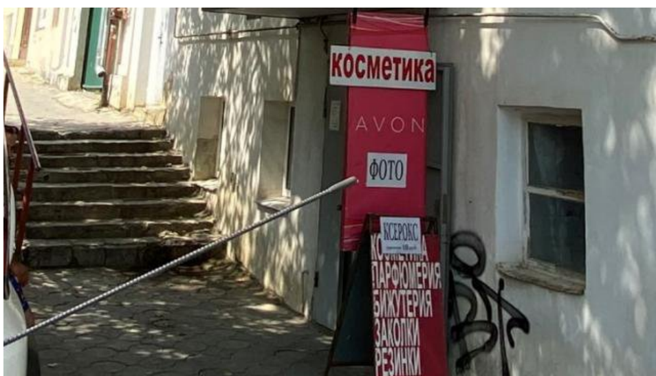
Оконные проемы цокольного этажа
