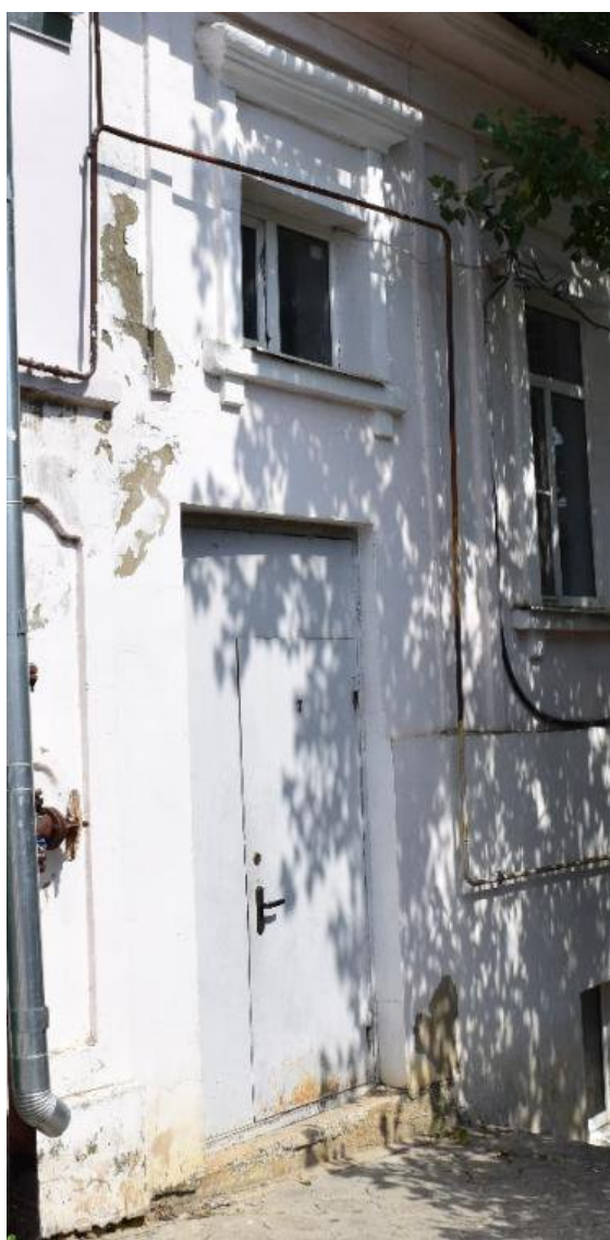
Главный вход в здание с люнетом
