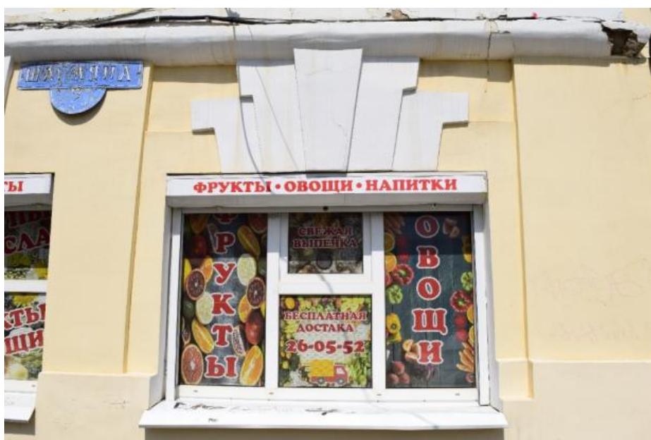
Декоративные элементы: ниша первого этажа с оконным проемом, рустованная шапка с замковым камнем
