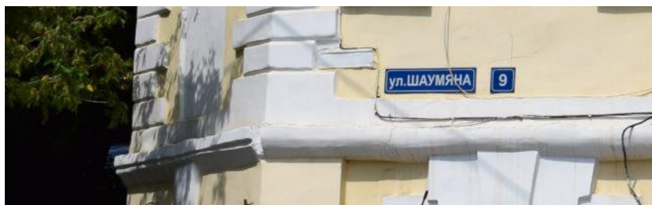
Декоративный элемент: межэтажный карниз
