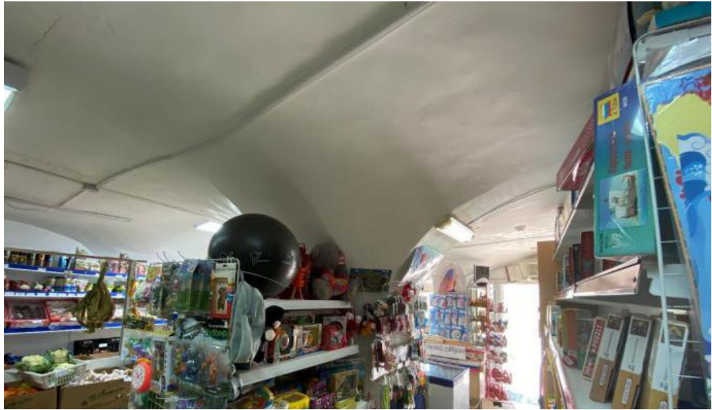
Крестовые своды цокольного этажа
