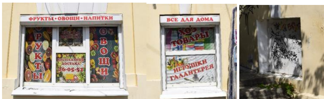
Оконные проемы цокольного этажа, главного южного фасада
